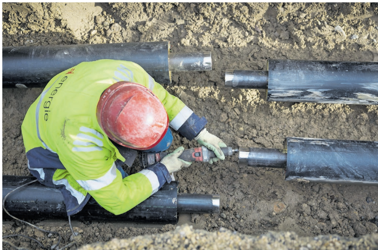
Am liebsten direkt vor der Haustür: Liegenschaftsbesitzer stellen meist erst dann auf Fernwärme um, wenn die Leitungen in ihrer Nähe fertig verlegt sind.
